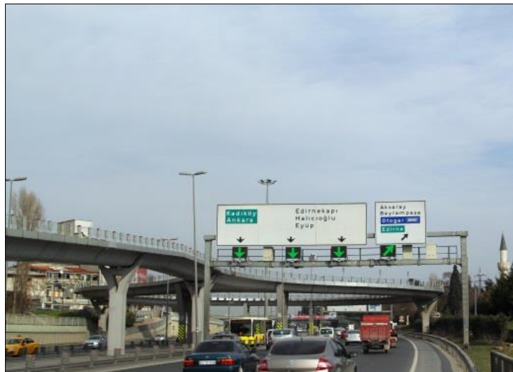
Şekil 4.29: Şerit Yönetim Sistemi, 2013
