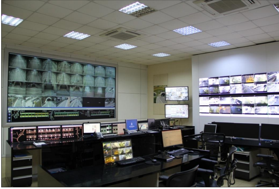
Şekil 4.37: Tünel İşletim Merkezi, 2013
