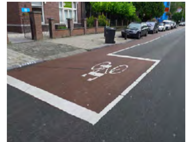
Şekil 75: Bekleme çizgisi (Advanced stop line-ASL)
