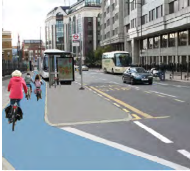
Şekil 119: Otobüs durak alanı ve bisiklet yolu düzenlemesi
