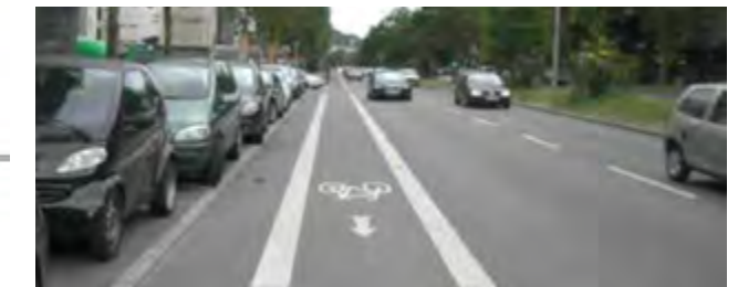
Şekil 68: Şeride paralel olarak park edilen araçların kapılarından bir koruma mesafesi uzaktaki bisiklet şeridi (Planungsgemeinschaft Verkehr-PGV ve Alman Yol Güvenliği Konseyi-DVR)
