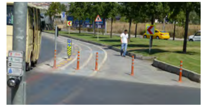
Şekil 71 Yaya geçidinde bulunan engelli rampaları
