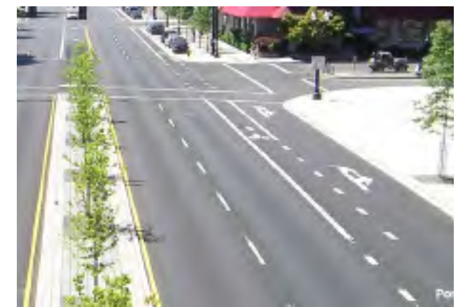
Şekil 118: Kavşak geçişi dahilinde bisiklet şeridi uygulaması
