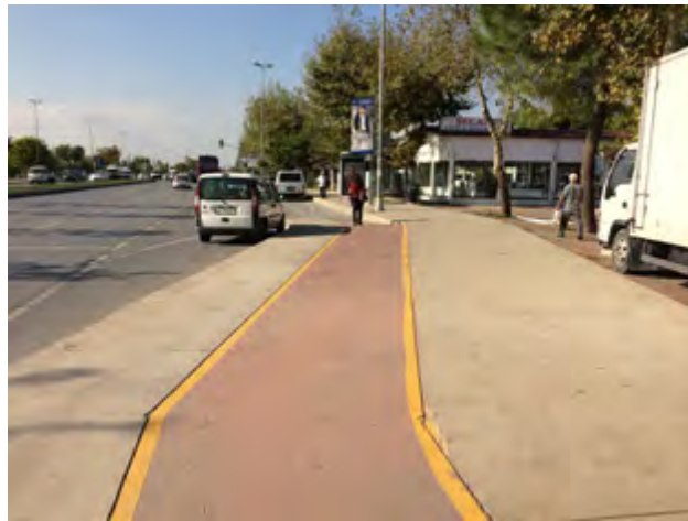
Şekil 114 Yaya ve bisikletli geçişi için yatay işaretleme örnekleri
