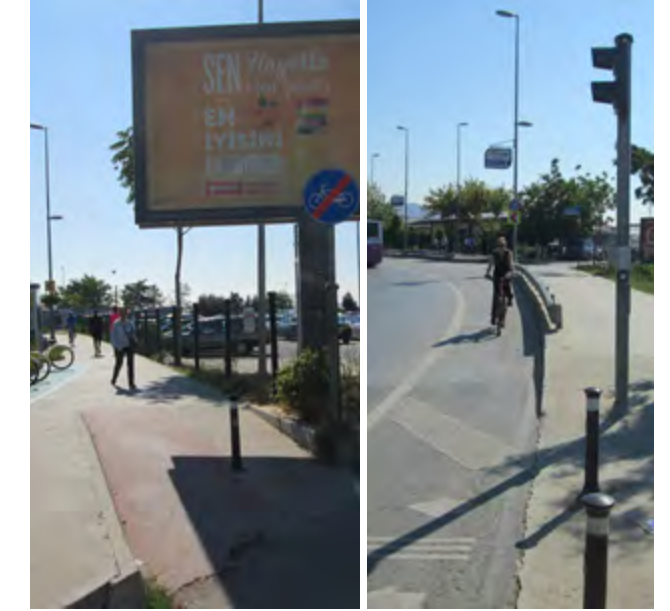
Şekil 108 Bostancı İDO Önü Geçişi
