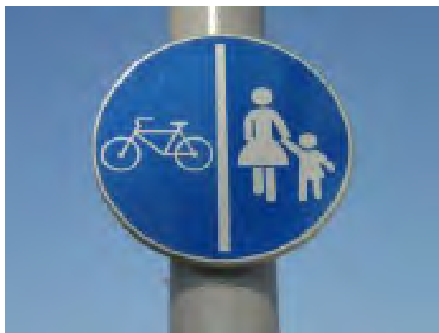
Şekil 115: Yaya ve bisikletli yol kullanıcı türleri için dikey işaretleme örneği
