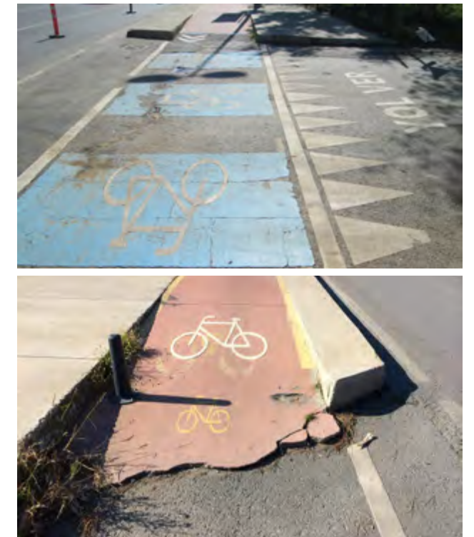
Şekil 99 Bisiklet yolu üzerindeki deformasyon
