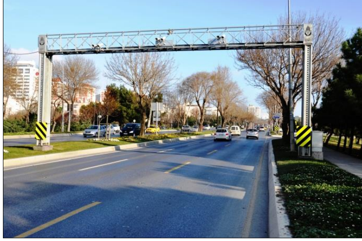
Şekil 4.22: Koridor Hız İhlal Tespit Sistemi, 2013
